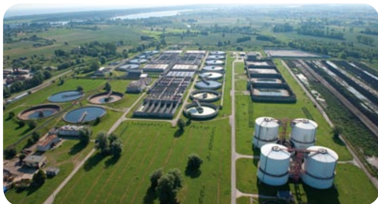
Widok oczyszczalni ścieków „Gdańsk-Wschód” Źródło: materiały GIWK Sp. z o.o.
